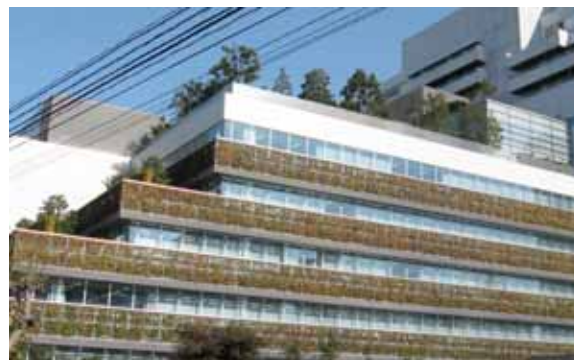
壁面緑化により圧迫感を軽減した事例（東京都千代田区）
