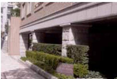
植栽により街並みに配慮した駐車場の事例（東京都港区）
