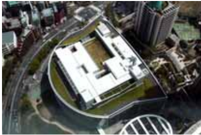
見下ろし景観に配慮した設備類を修景した事例(東京都港区)
