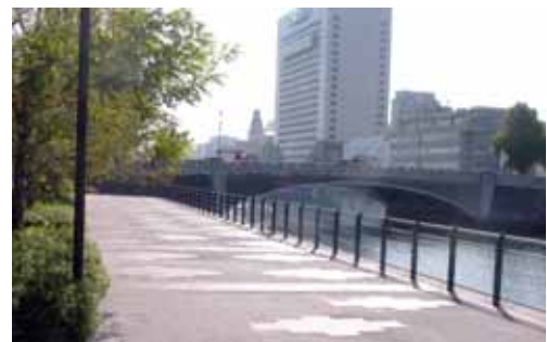
橋詰め空間（万国橋）
