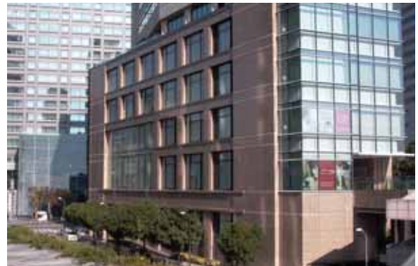
石の素材感を生かした外壁の事例(中央地区)
