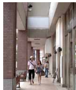
1階部分の壁面後退
