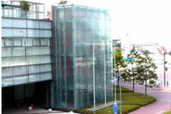
沿道景観に配慮した外階段のデザイン
