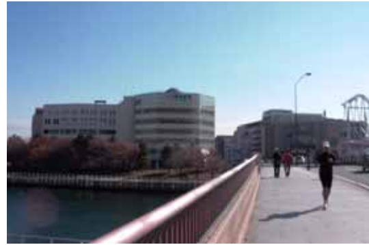
地区の玄関口としての橋（国際橋）
